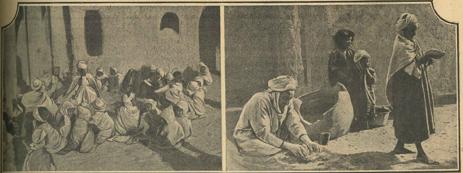
L'ÉCOLE DES MARABOUTS, A EL OUED. A DROITE, UN INDIGÈNE MALAXE AVEC SES MAINS DU GYPSE ADDITIONNÉ D'EAU. DE LA MÊME FAÇON, UN JEUNE MANŒUVRE TRANSPORTE LE MORTIER DESTINÉ A LA CONSTRUCTION D'UNE MAISON.
