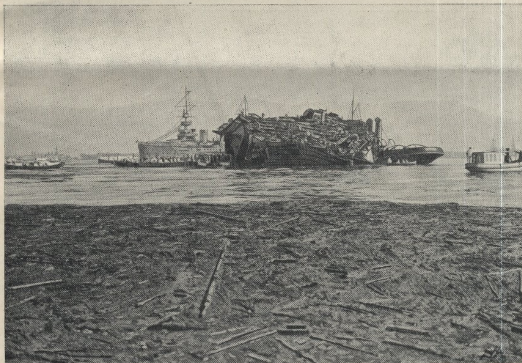
Fig. 3. — La rade de Toulon après l'explosion de la Liberté . Les premiers travaux de sauvetage.
